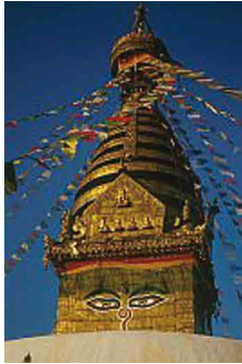
中央佛塔的頂部
